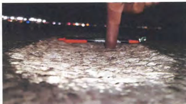
Fig. 1.4.3. Profundidad de los daños en la pista
