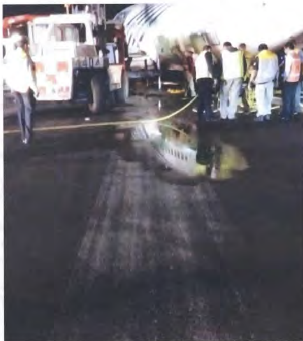
Fig. 1.4.1. Daños por arrastre a la superficie de la pista
