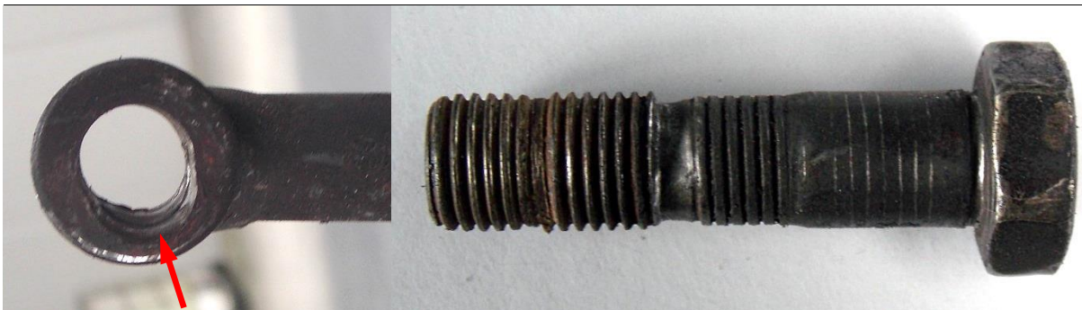
39, 40- Końcówka zastrzału turbodoładowarki lewego silnika z silnie zowalizowanym otworem i w znacznym stopniu zniszczona śruba mocowania, pracująca w tym otworze. Stan obu elementów świadczy, że proces ich degradacji był długotrwały, został spowodowany drganiem i nie był wykryty przez długi czas.
