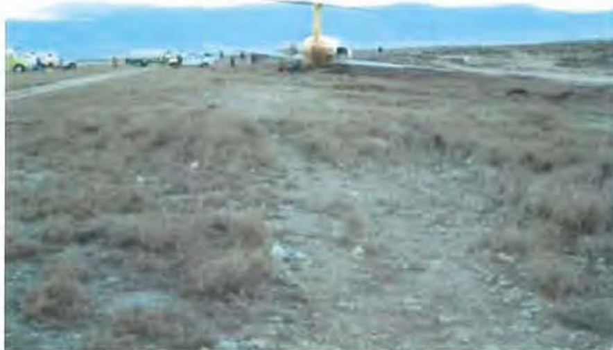
Fig. 1.9.1. Imagen se aprecian las condiciones de la franja de pista en malas condiciones
