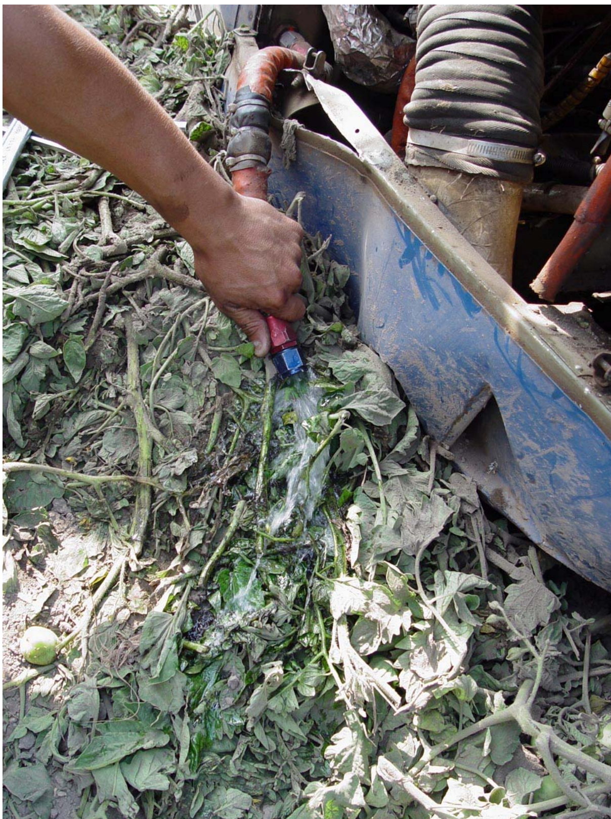
Pequeño flujo de combustible obtenido al poner en funcionamiento la bomba del motor izquierdo.
