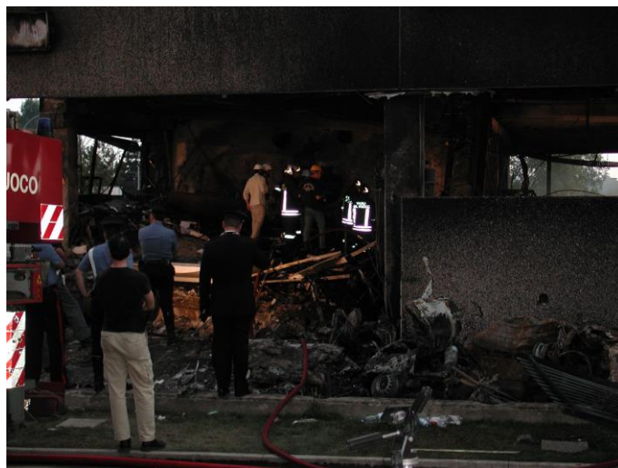
Foto 18: evidenze dell'incendio a seguito dell'impatto.
