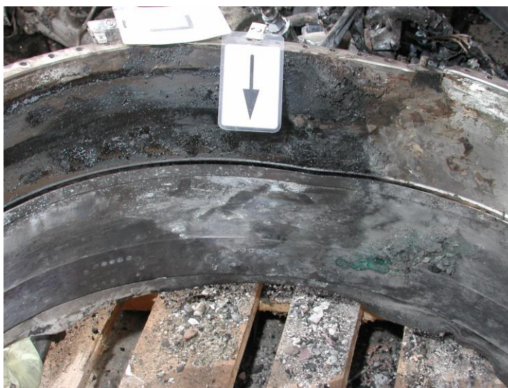
Foto 20: tracce di sfregamento sul case del fan.
