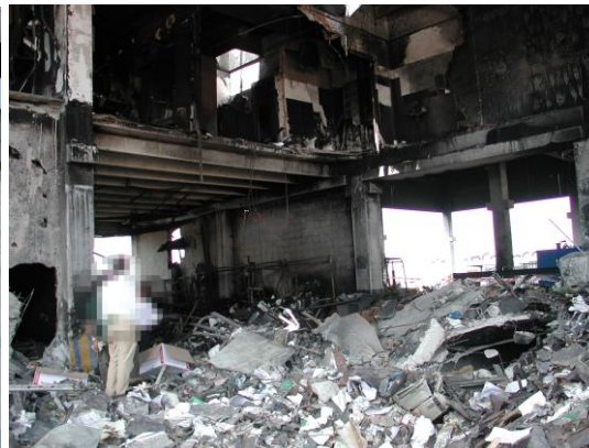
Foto 8: interno del capannone.
