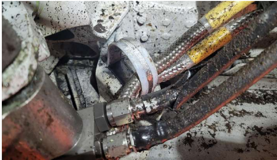
Imagen 56: Estado de la línea de retorno del conjunto de la válvula secuencial de bloqueo descendente del tren principal de aterrizaje izquierdo (LH MLG).
